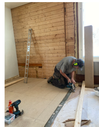
Gunnar Smedberg under arbetets gång med nya toaletter.
