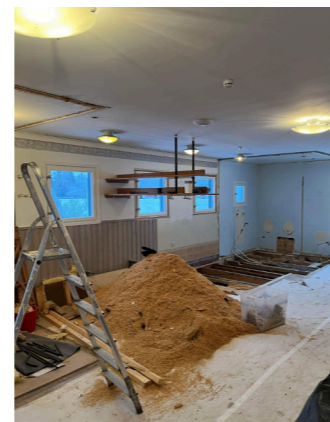
Foajén under ombyggnationen.
